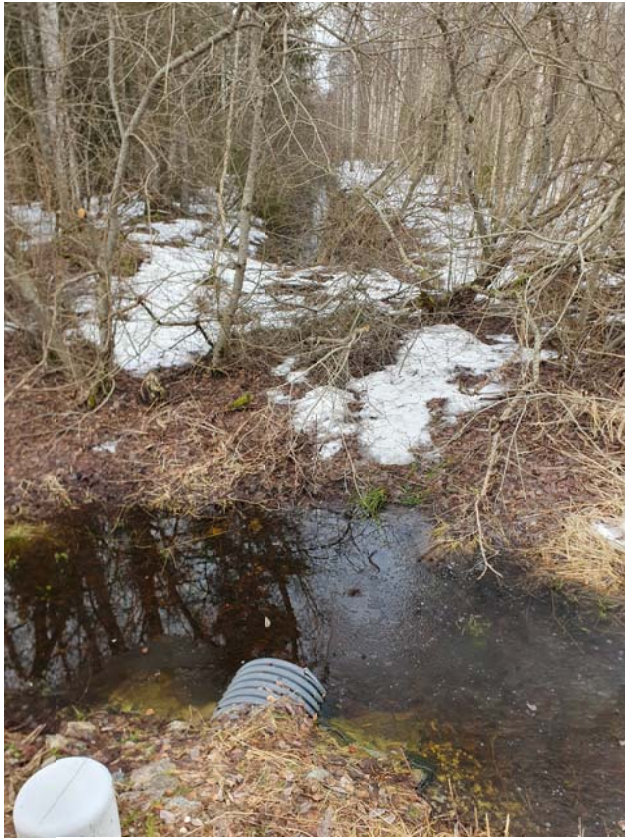
Foto 5. Truubi T/56 äravool on kinni ning vajab lahti kaevamist, kraav 101 on vajalik rekonstrueerida.
